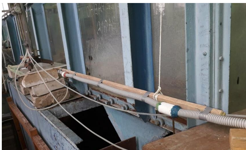
Рис. 5. Крепление пьезометров к горизонтально расположенной ПВХ трубе
