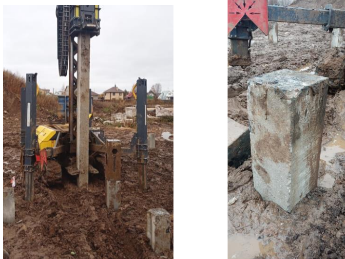
Рис. 3. Забивка свай, армированных АСК, на строительной площадке
