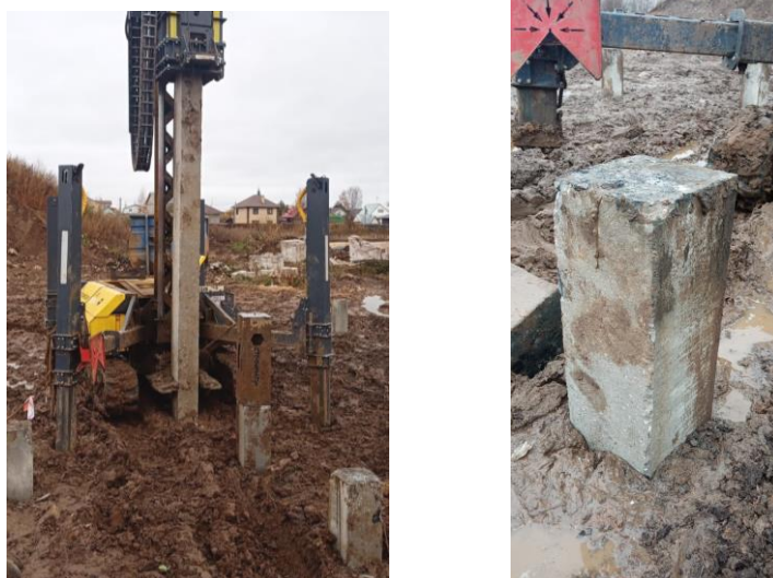
Рис. 3. Забивка свай, армированных АСК, на строительной площадке
