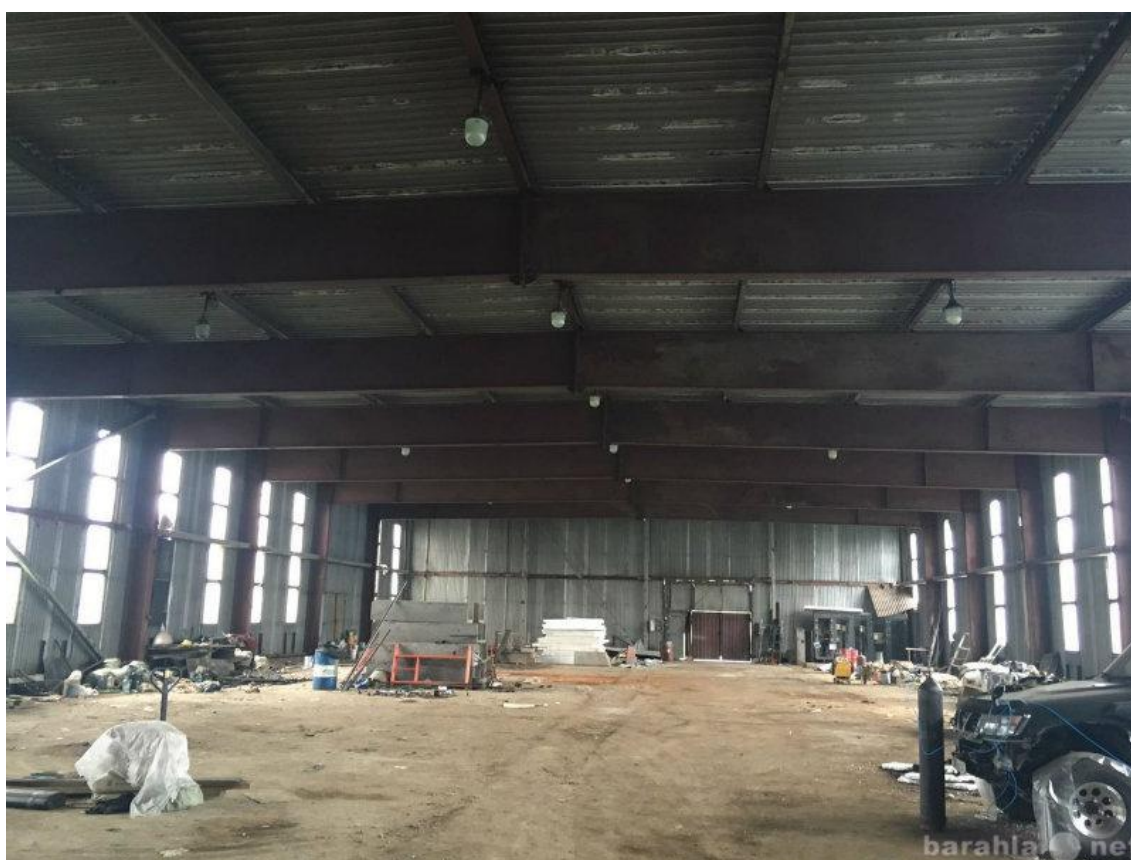
Рис. 3. Пример здания с балкой типа «Канск» [3]
