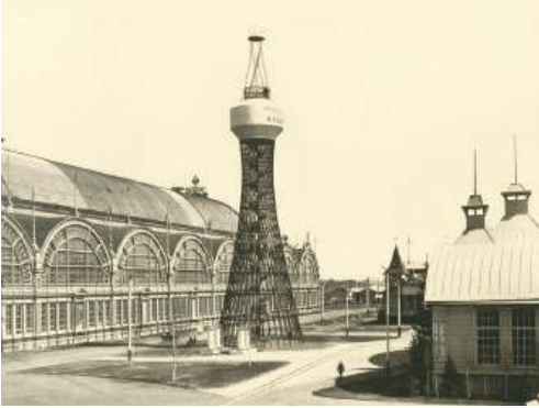
Гиперboloидная башня. Инженер В. Г. Шухов
