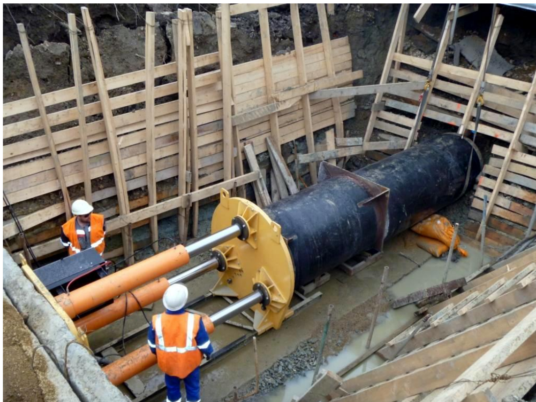
Рис. 5.15. Установка для прокладки трубопроводов продавливанием
