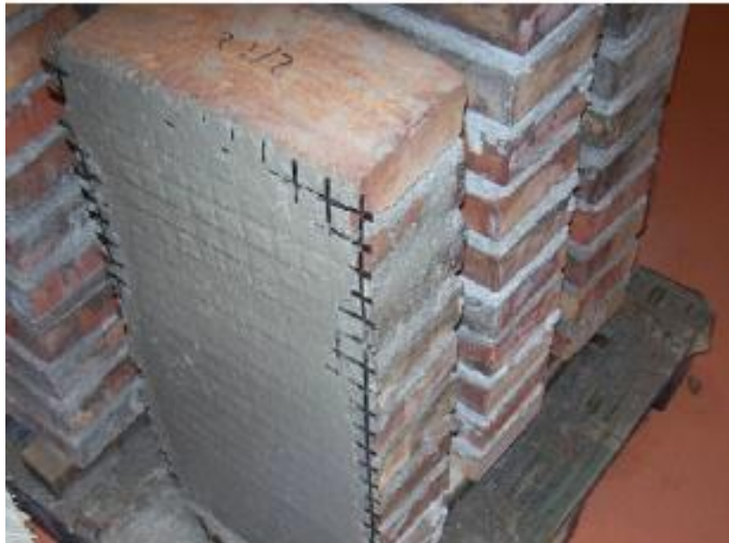
Рис. 1. Усиление наружного защитного слоя кирпичной кладки полимеркомпозитной сеткой
