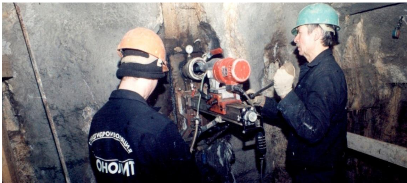
Рис. 4. Алмазное бурение разведочной скважины через пробку заглушенного аварийного участка перегонного тоннеля метрополитена «Пл. Мужества» – «Лесная», г. Санкт-Петербург
