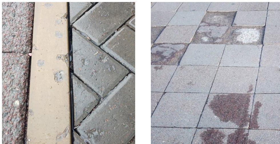
Рис. 5. Сколы на платформе при механических воздействиях
