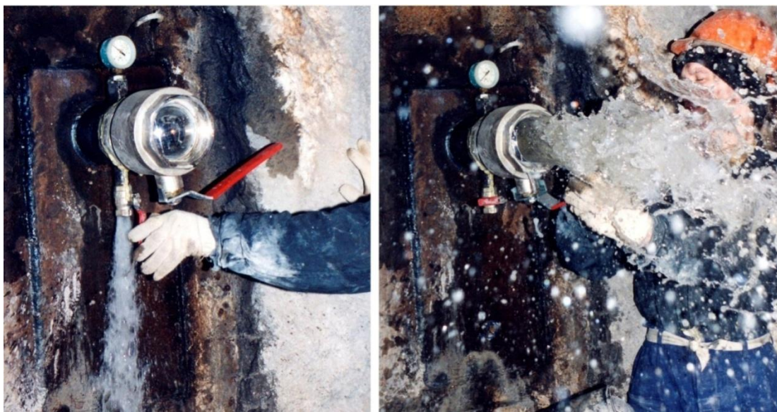
Рис. 5. Наглядная демонстрация гидростатического давления на заглушенном участке тоннеля метрополитена «Пл. Мужества» – «Лесная», г. Санкт-Петербург
