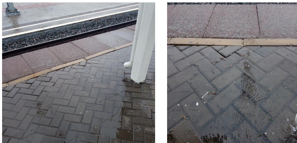
Рис. 6. Скопление воды на платформе
