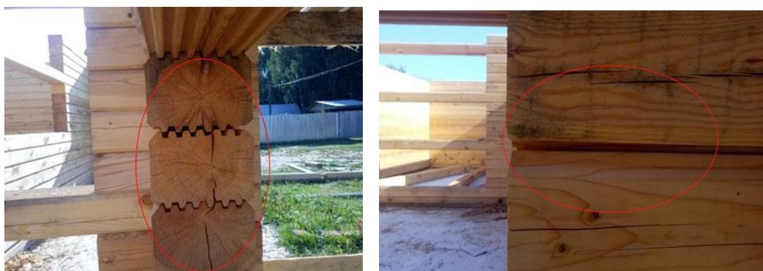
Рис. 4. Зазоры в пазах и плесень
