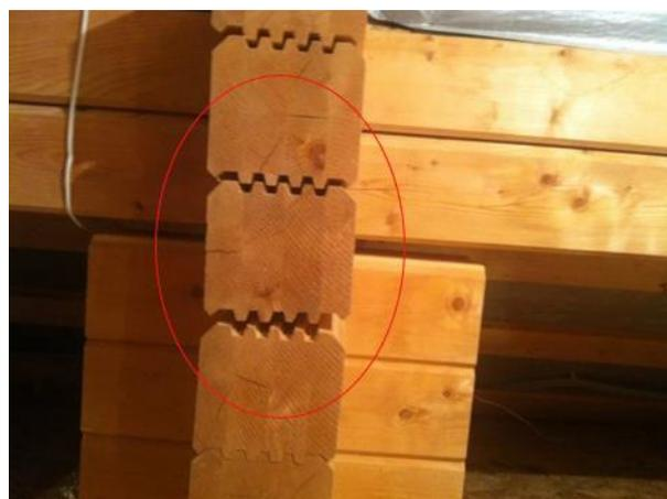
Рис. 3. Зазоры
