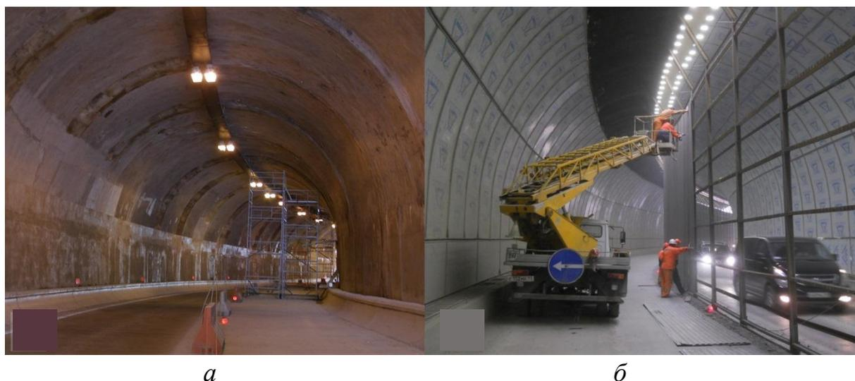
Рис. 1. Капитальный ремонт с гидроизоляцией железобетонной обделки автодорожного тоннеля на магистрали Адлер – Красная Поляна: *а* – подготовка к выполнению работ; *б* – завершение работ, демонтаж временных ограждений
