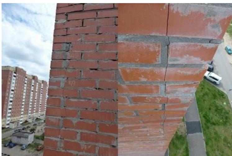
Рис. 1. Трещины в угловых зонах кладки
