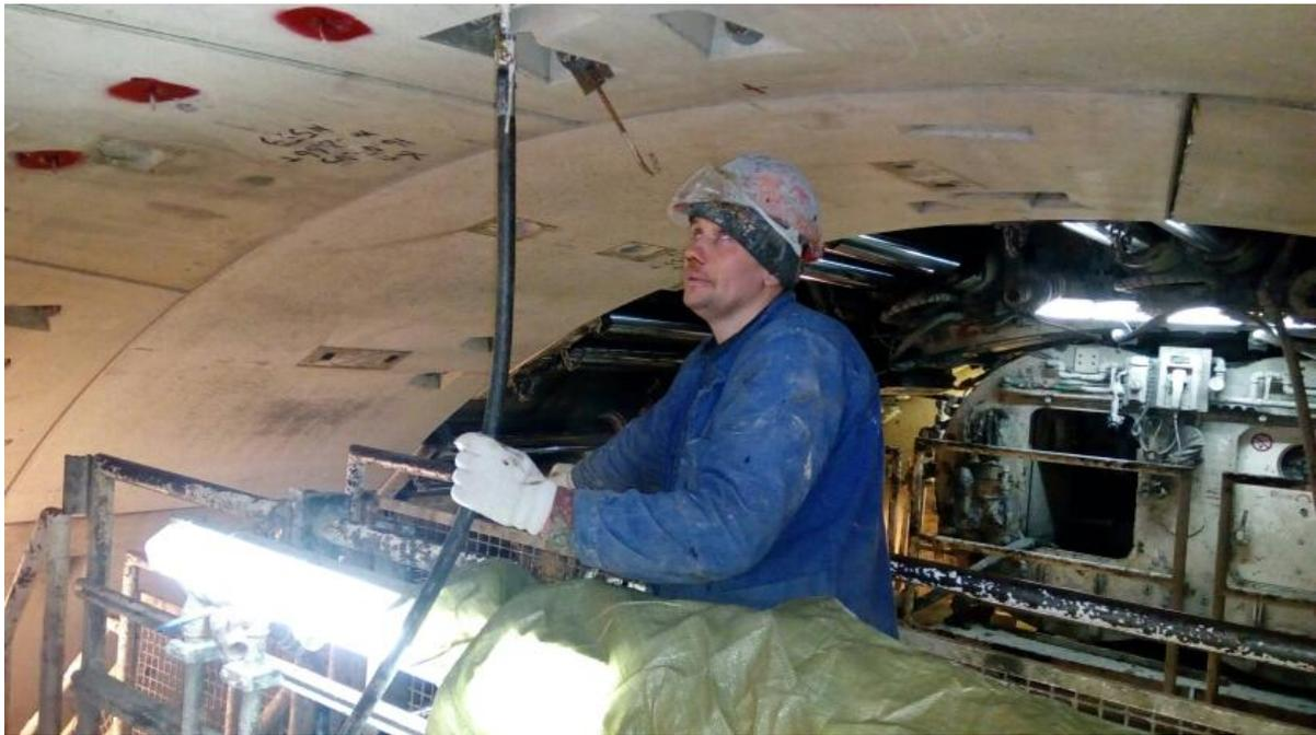
Рис. 2. Нагнетание двухкомпонентного полиуретанового состава «Тимпол 111/7» с увеличенным коэффициентом расширения за тоннельную обделку в зоне работы проходческого щита на участке «станция «Беговая» – станция «Новочеркасская»» (фото автора)
