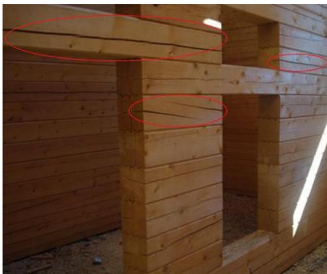
Рис. 5. Дефекты стеновых конструкций
