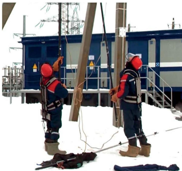
Рис. 3. Установка с помощью экзоскелета переносных заземлений на воздушных линиях
