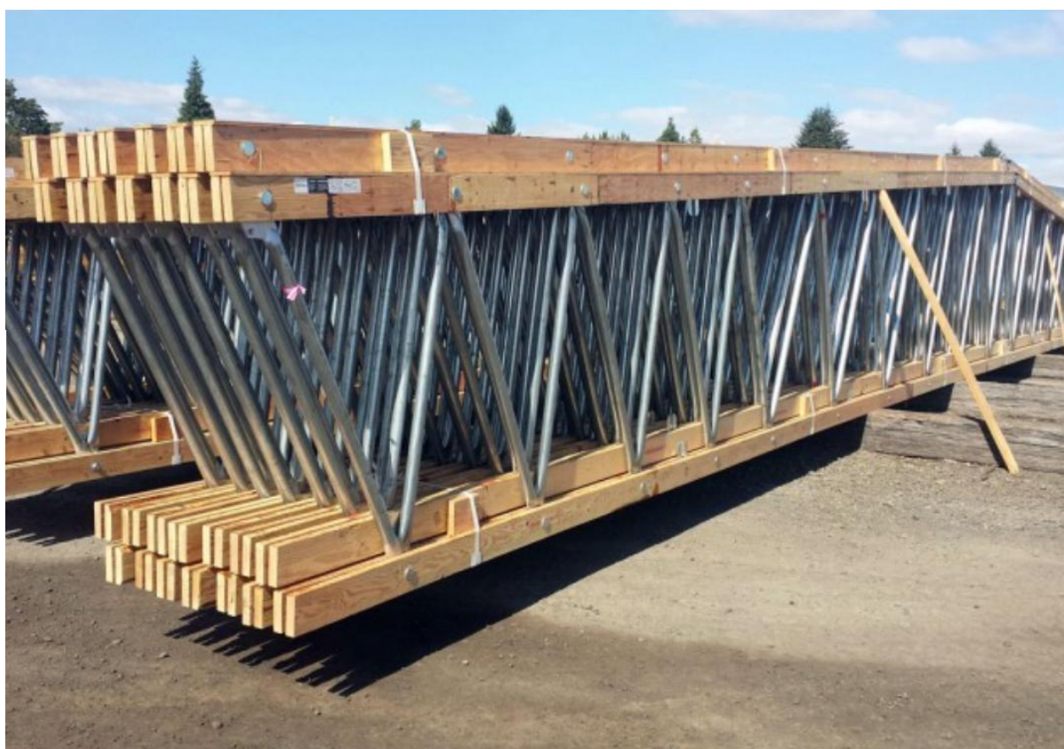
Рис. 4. Металлодеревянная ферма с решеткой из круглых труб
