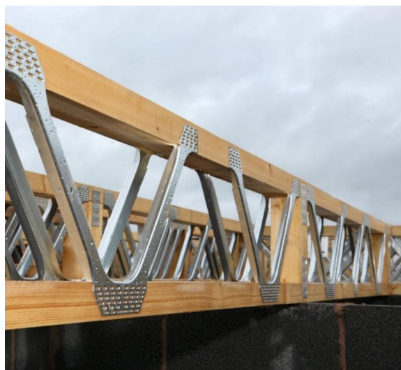
Рис. 3. Металлодеревянные фермы на МЗК
