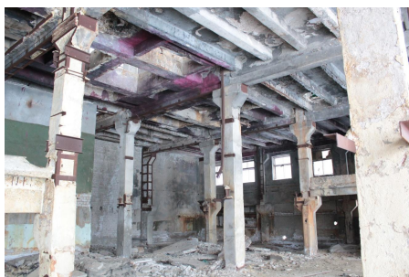
Рис. 1. Общий вид колонн 1-го этажа производственной зоны
