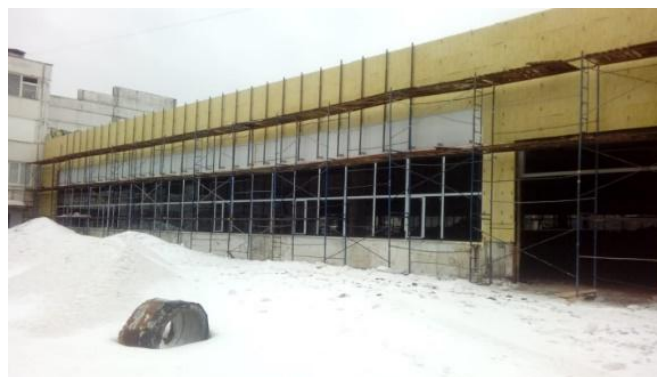
Рис. 2. Здание в процессе реконструкции
