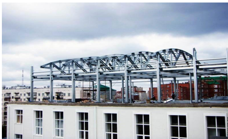
Рис. 1. Надстройка этажа по технологии ЛМК
