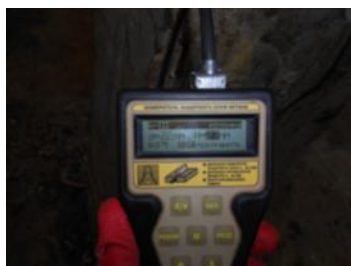
Рис. 4. Фотофиксация значений измерений толщины защитного слоя бетона
