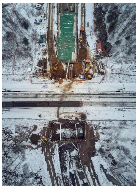
Рис. 4. Продавливание секций экрана с сохранением скорости движения поездов до 140 км/ч
