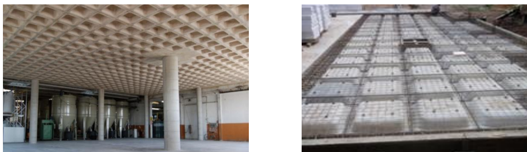
Рис. 3. Монолитное кессонное перекрытие, выполненное с применением инвентарной объемной опалубки
