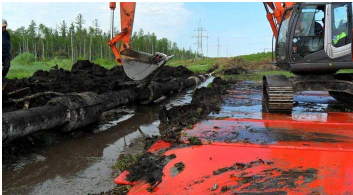
Рис. 2. Временное дорожное полотно из композитных замковых плит типа МДП «МОБИСТЕК»
