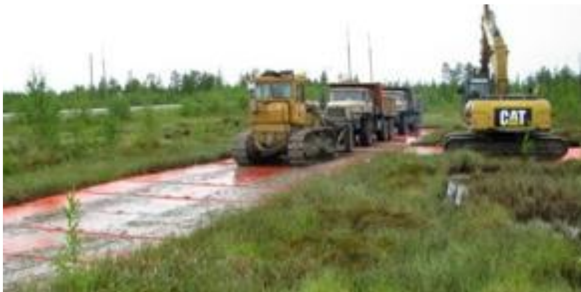
Рис. 3. Обустройство площадки из композитных замковых плит типа МДП «МОБИСТЕК»
